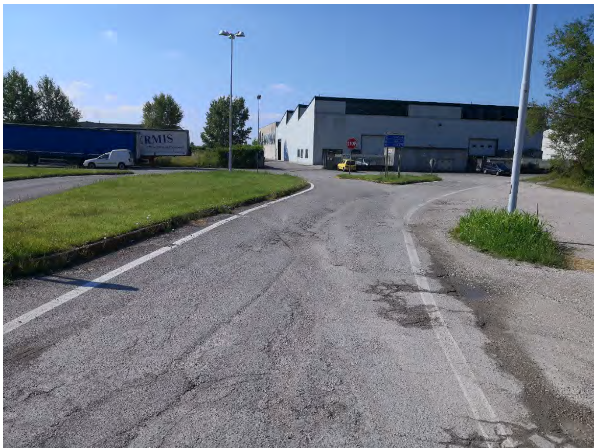
Buche e ormaie sulla viabilità della zona industriale di Cividale
