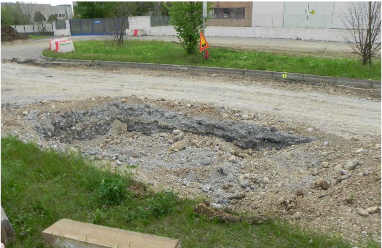
Intervento di risanamento di viale del lavoro in ZIU
