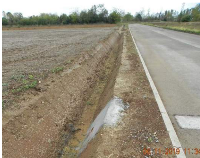
Interventi di sistemazione idraulica su viale dell'Artigianato in ZIU
