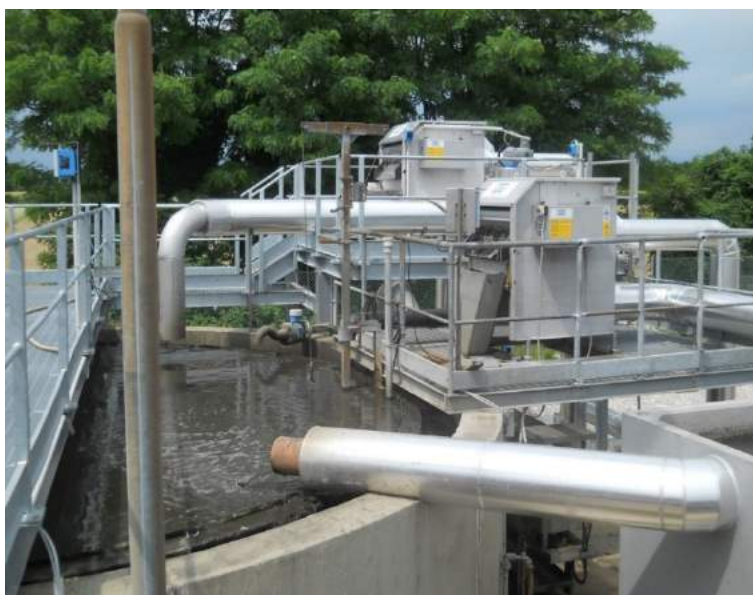
Impianto di depurazione ZIAF: sezione di pretrattamento acque reflue industriali in ingresso
