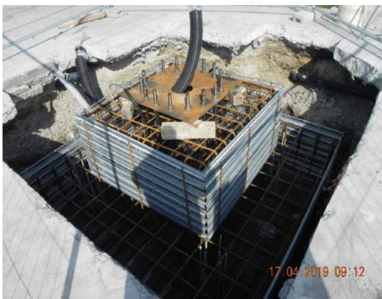
La gabbia in acciaio prima dei getti di calcestruzzo costituente il plinto di fondazione di una delle torri.
