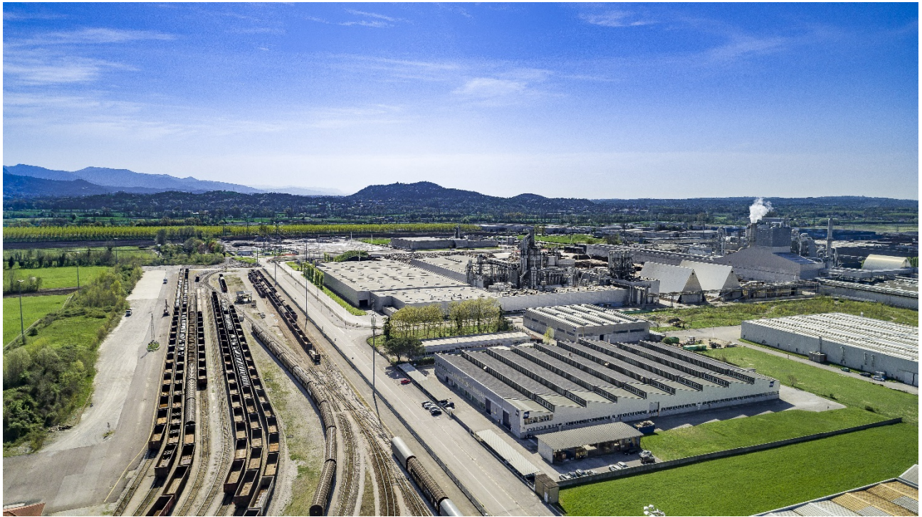
Scalo ferroviario Osoppo
